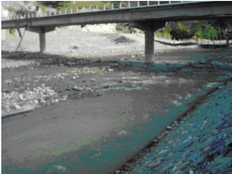
**Descripción del Proyecto** - El proyecto consistió en la construcción de un puente de 3 luces con una longitud total de 106.00 metros, con un ancho de pista de 8.00 metros y banquetas laterales de 1.00 metro de ancho cada una.
