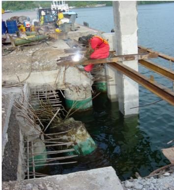
**Demolición submarina** – La demolición submarina requirió de equipo y personal especializado que incluyó submarinistas y quijadas hidráulicas especiales, durante la ejecución del proyecto se utilizó equipo de seguridad especial y se tomaron las medidas necesarias para la preservación del medio ambiente submarino.
